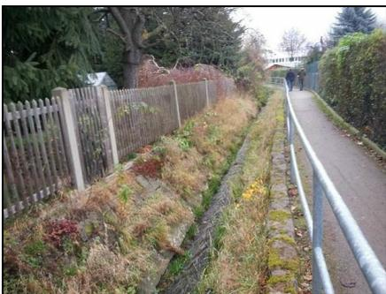
Abb. 1: vor Maßnahmeumsetzung; ausgebautes Trapezprofil im Bereich des Heydenreichweges, 01.10.2019
